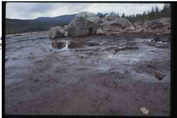
Fig. 1. Eikredammen er inntaksmagasin (vanligvis mellom kote 566 og 562) på dammen..
